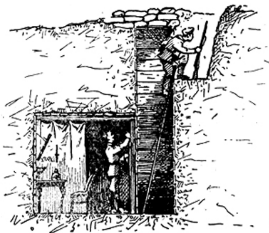
Deuxième genre d'abri allemand, moins fréquent, avec accès par un puits.
